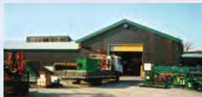
新工場の建設
