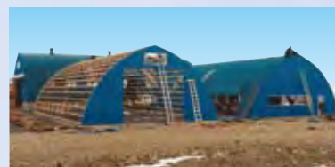
土幌工場（現・旧工場）の建設
